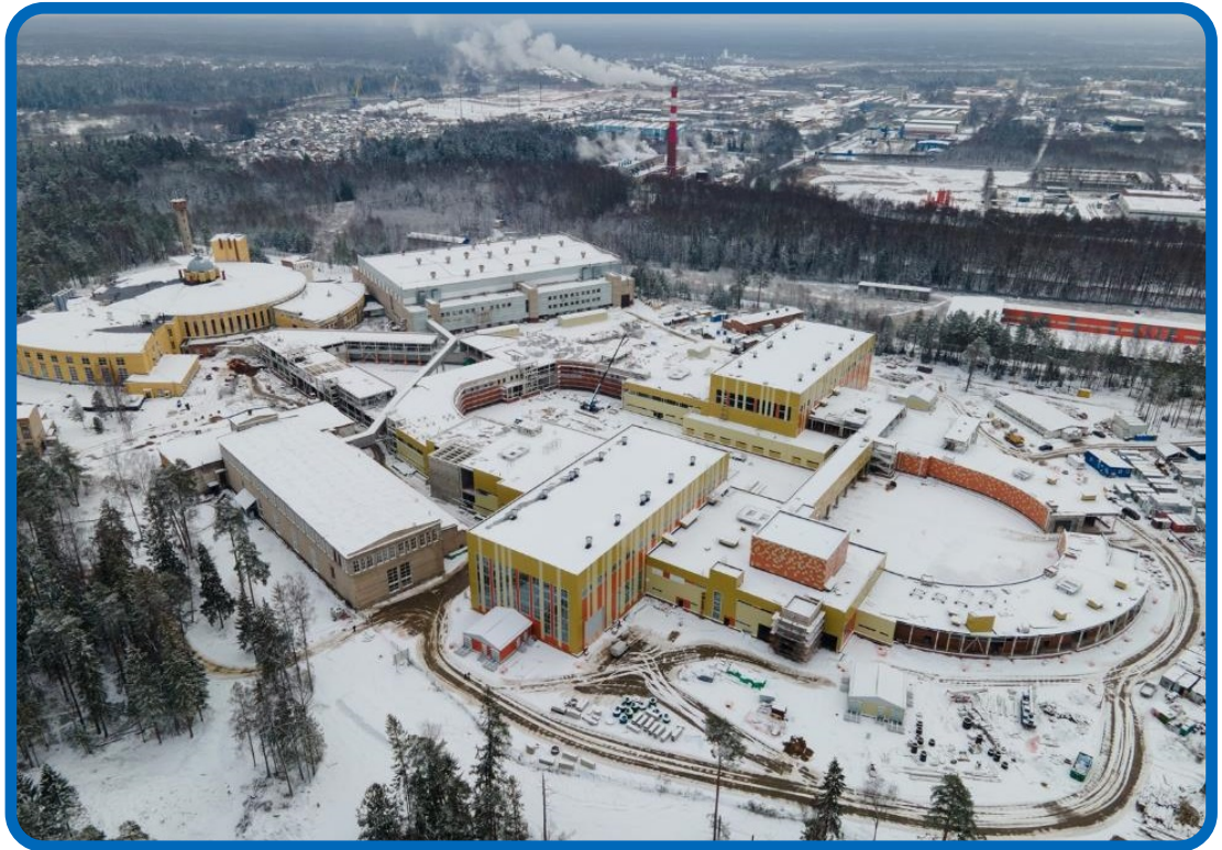
Общий вид строительной площадки. General view of the construction site.
